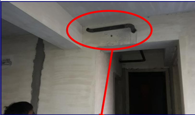
बिल्डिंग की बीमों में ड्रिल कर डाले जा रहे पानी के पाईप
